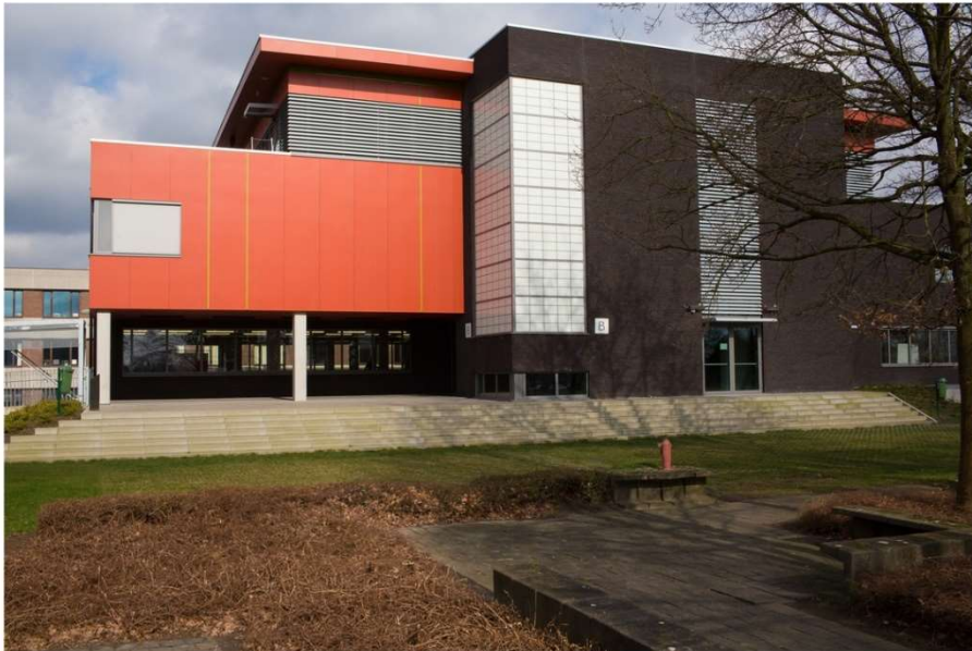
Figuur 1. KCE gebouw (More, sd)
